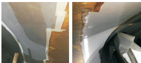
图7 补焊区域喷砂和涂装处理
