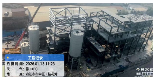
千吨级固废矿化中试验台及白马万吨级矿化示范装置建设
