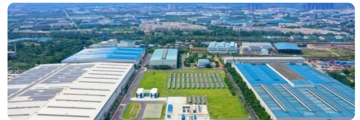
东方锅炉大力推动绿色电力消费，积极优化能源结构。在德阳园区建设光伏发电系统，年发电量约300万千瓦时，践行“自发自用”模式，年等效减少碳排放约1700吨。此项举措与智慧能源管理相结合，有效降低了对外部化石能源的依赖，为生产运营注入了绿色动能。
